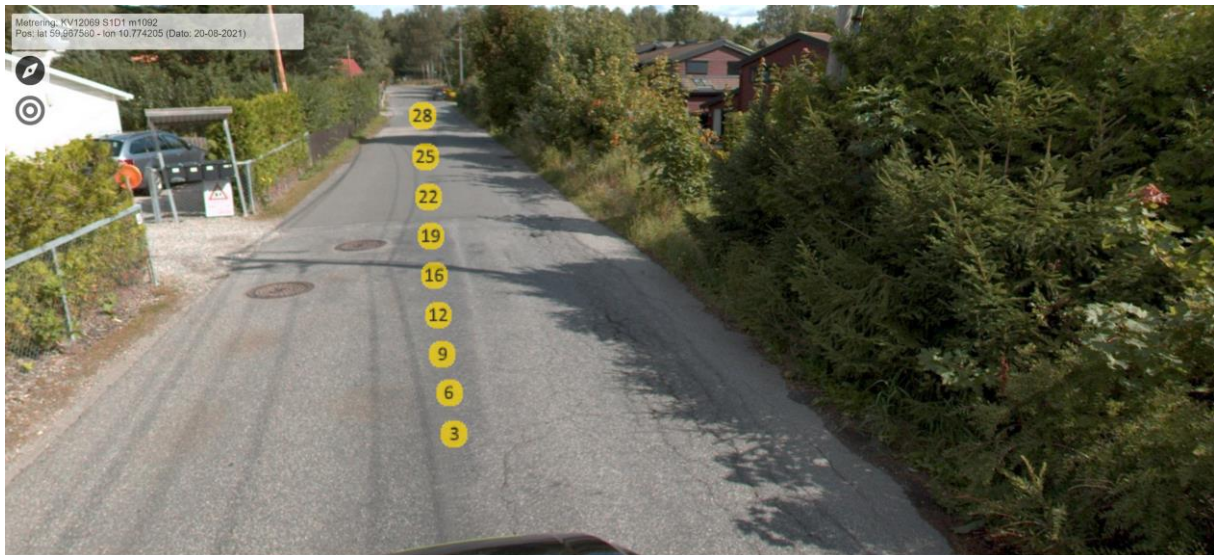
Figur 10a. 360-graders bilde i Frysjavaen nr 48A (Kv 12069). Her sees bl.a. dekkeskader langs høyre halvdel av veien.
