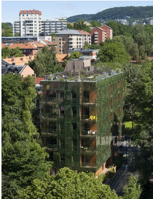
D36 The Greenhouse Foto: Finn Ståle Felberg Arkitekt: Element Arkitekter AS
